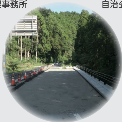
道路整備作業
